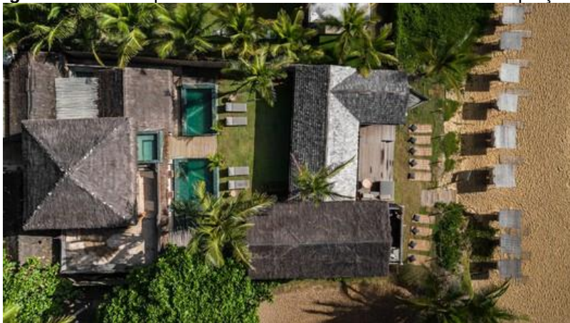
Figura 8 - Vista Superior da Pousada mostrando o telhado de piaçava.
