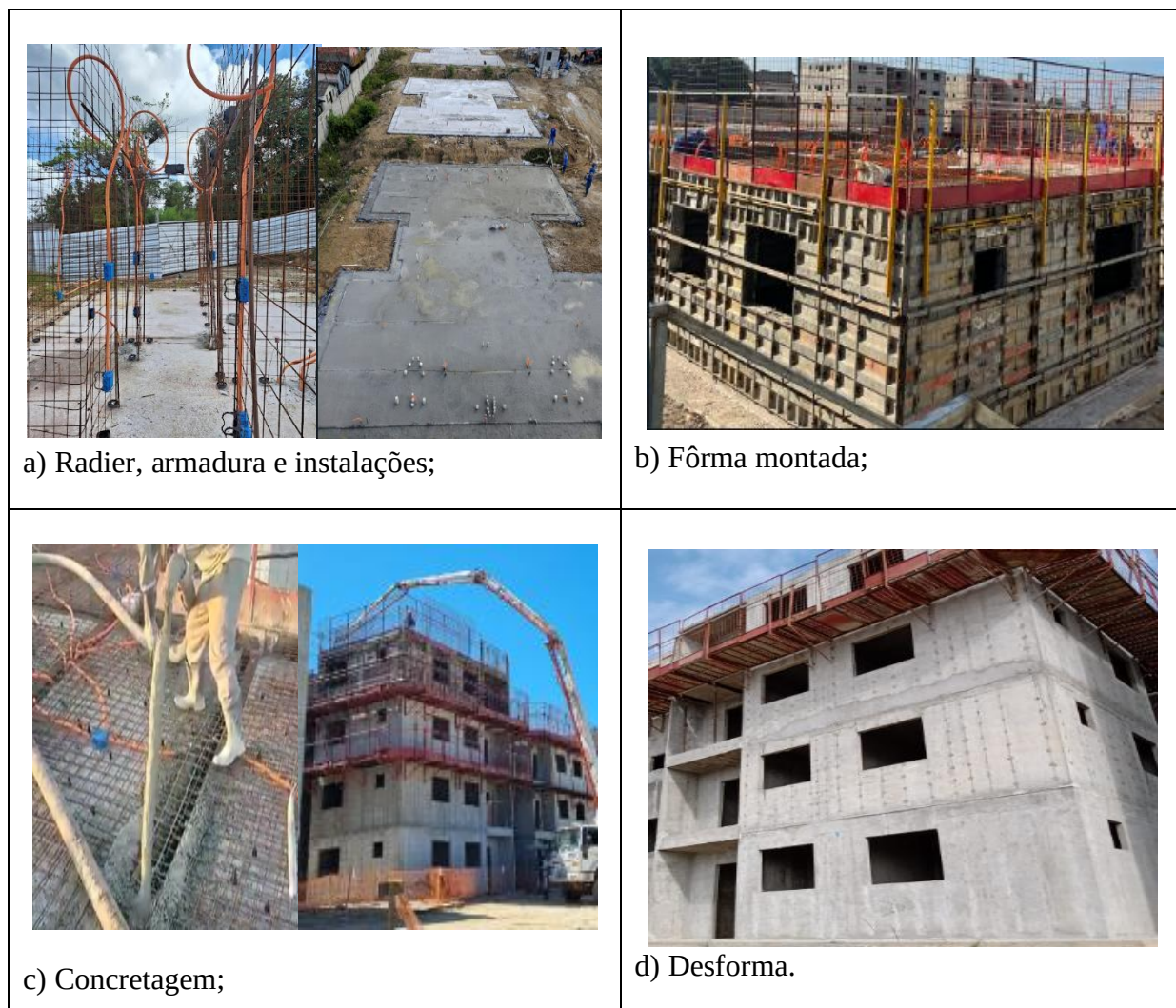
Figura 3 – Etapas do sistema parede de concreto.
