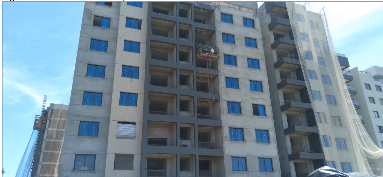
Figura 2 – Fachada frontal do prédio Havaí
