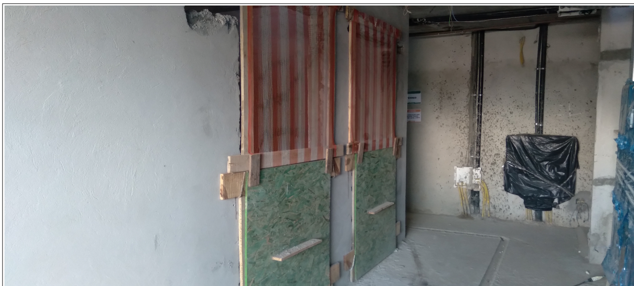
Figura 3: Poço duplo do elevador prédio Havaí. Pav. térreo (primeira parada do elevador).
