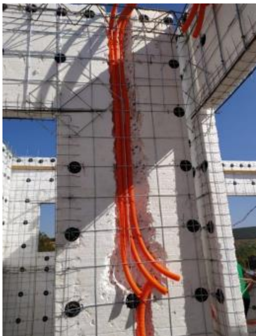
Figura 04 – Passagem de instalações elétricas.
