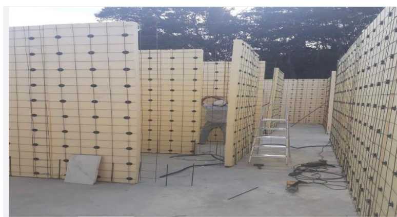
Figura 03 - Sistema de construção de placas EPS.
