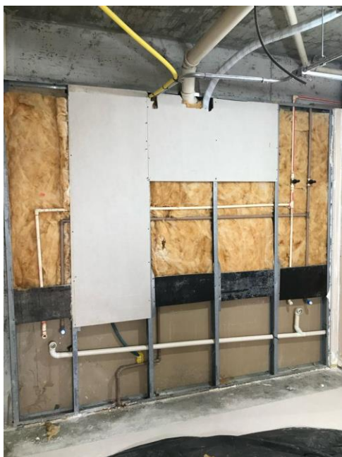
a) Instalações hidráulicas
