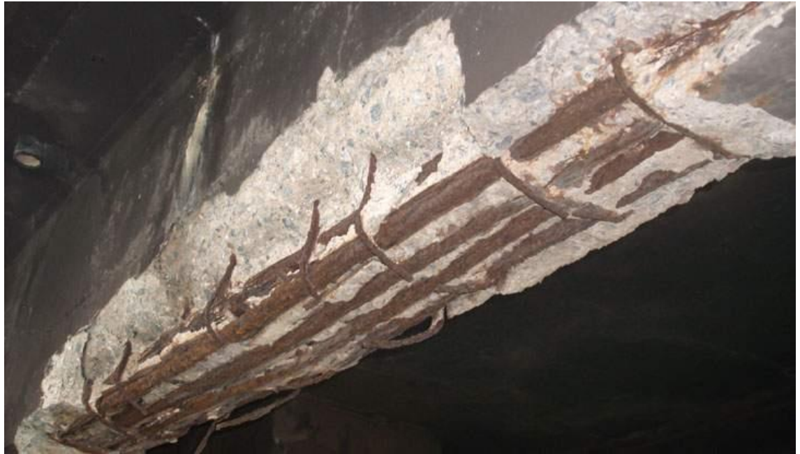
Figura 4 - Corrosão
