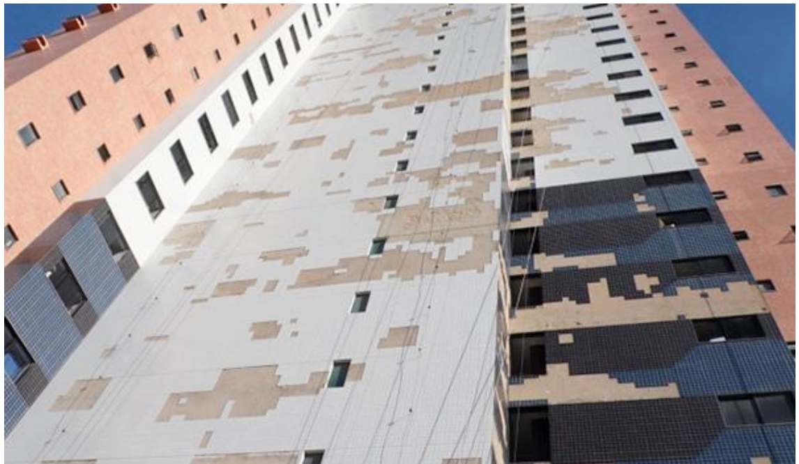
Figura 3 - Desplacamento
