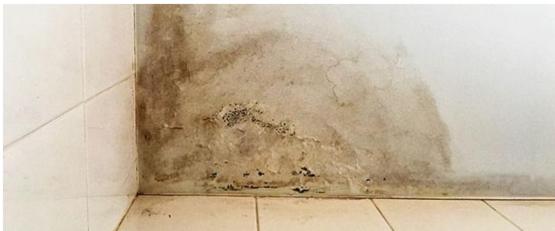
Figura 1 - Infiltração
