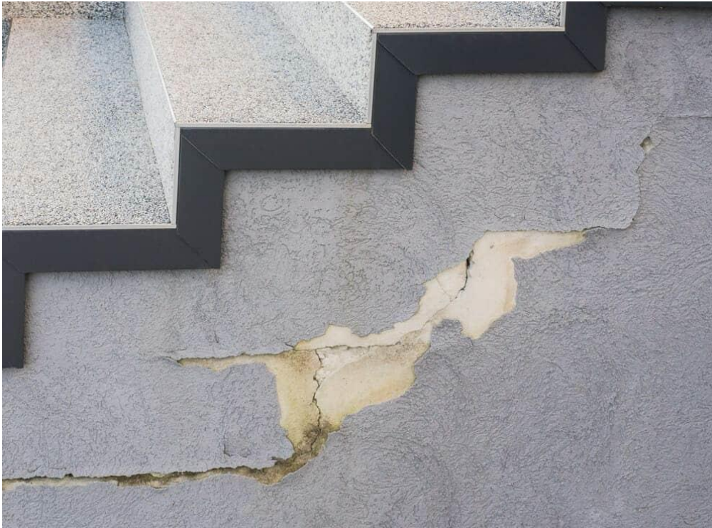
Figura 2 - Fissuras
