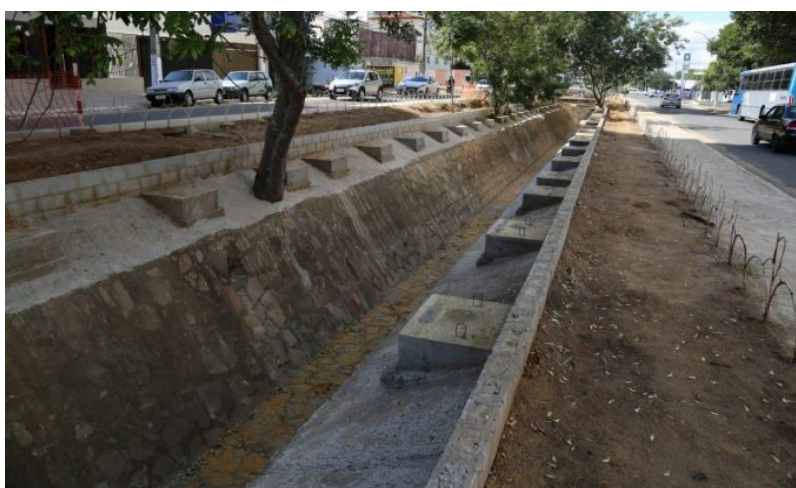
Figura 4 – Canal aberto na Avenida Olívia Flores
