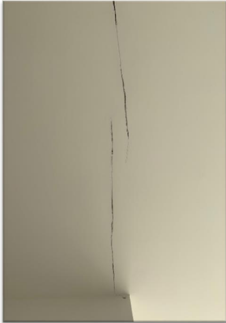
Figura 6 – Fissura aberta
