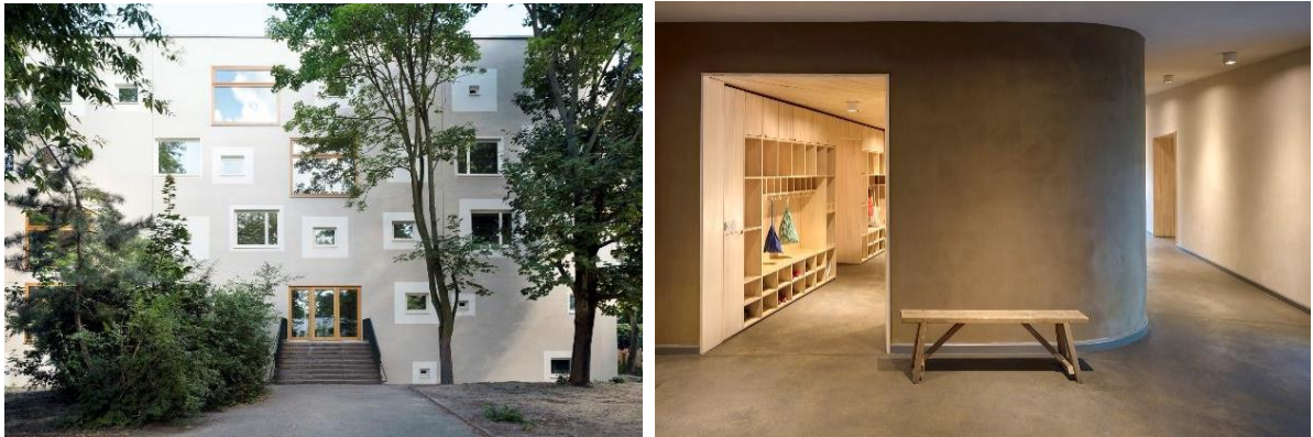
Figura 13 e 14 - Fachada depois da reforma e um corredor da escola, respectivamente
