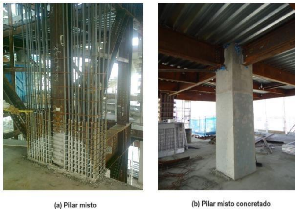
Figura 01 – Exemplo de pilar misto
