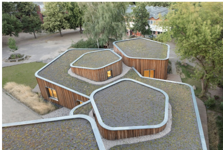
Figura 15: Visão do telhado verde, Creche e Escola Waldorf.
