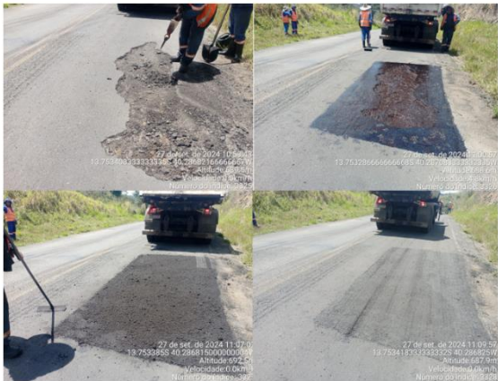
Figura 5 – Aplicação do Remendo Profundo
