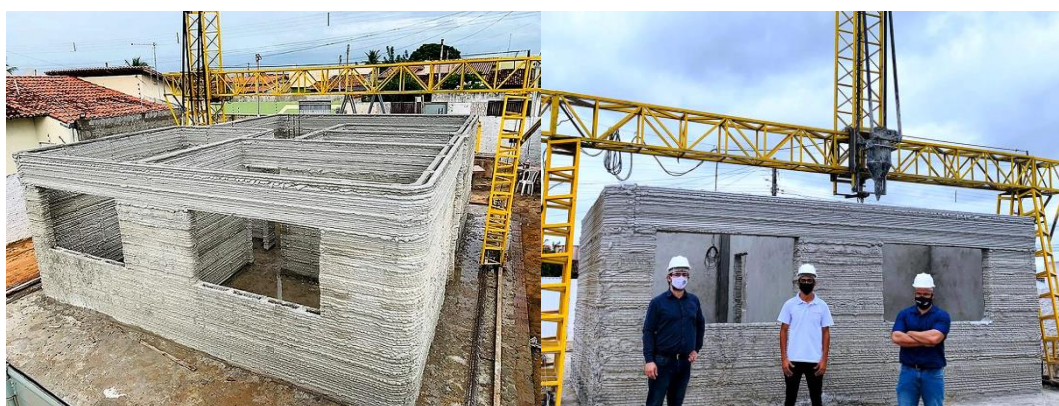
Figura 02: Estrutura da casa construída pela tecnologia 3D em de Macaíba-RN.
