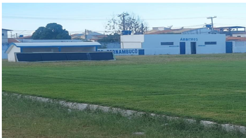
Fig. 23: Atual vestiário da arbitragem do estádio Paulo Coelho
