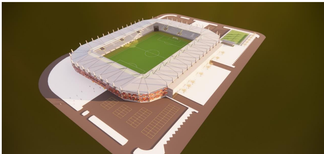
Fig. 36: Vista aérea do novo estádio Paulo Coelho
