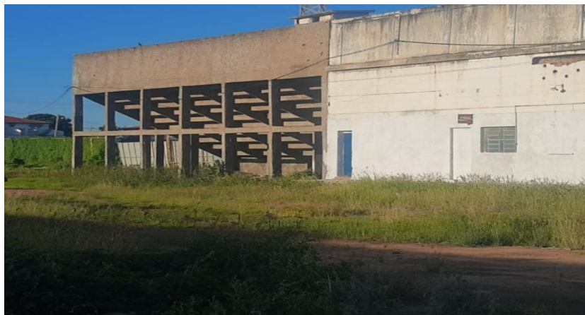
Fig. 28: Atual estrutura externa do estádio Paulo Coelho
