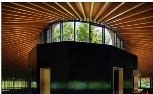
Figura 23 - Telhado do edifício.
