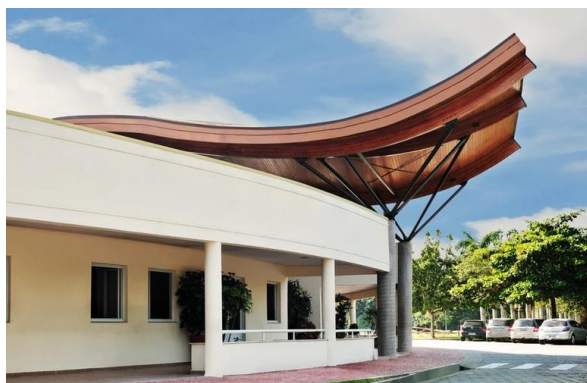
Figura 28 - Cobertura da capela.
