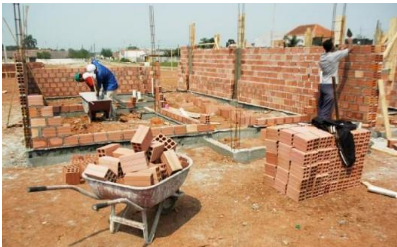
Figura 01 - Detalhe de uma estrutura em concreto armado com vedação de blocos cerâmicos.
