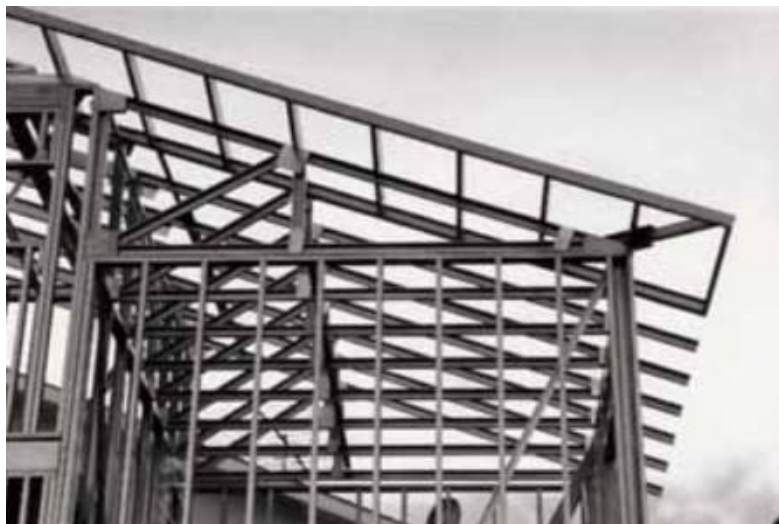
Figura 04 – Detalhe da estrutura do telhado em steel frame
